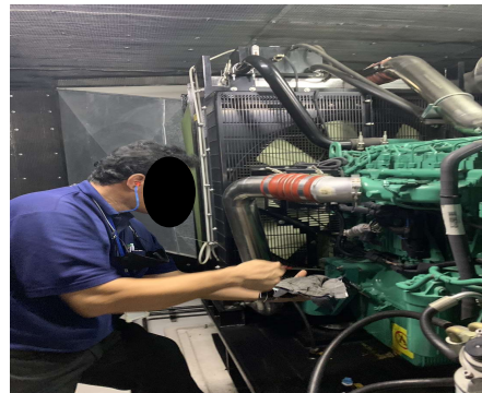
เจ้าหน้าที่ทำการตรวจสอบเครื่องกำเนิดไฟฟ้าสำรอง
