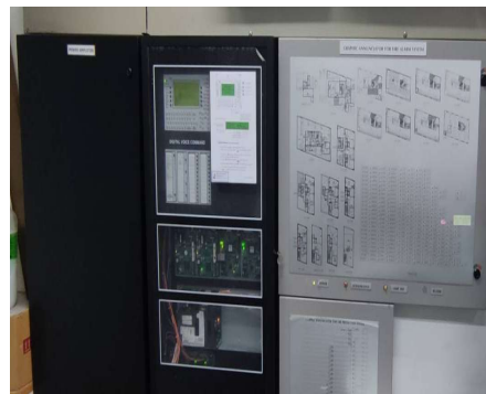
แผงควบคุมระบบแจ้งเหตุเพลิงไหม้
