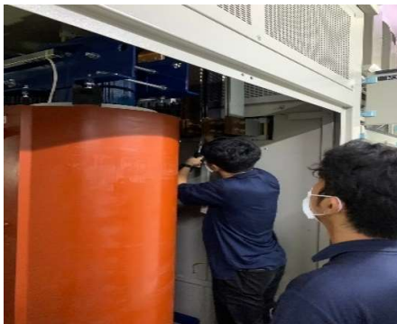
เจ้าหน้าที่ทำการตรวจสอบหม้อแปลงไฟฟ้า
