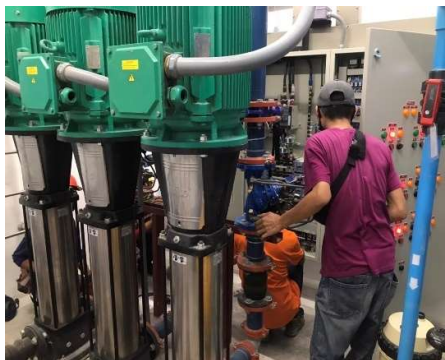
เจ้าหน้าที่ทำการตรวจสอบระบบสูบน้ำขึ้นดิน
