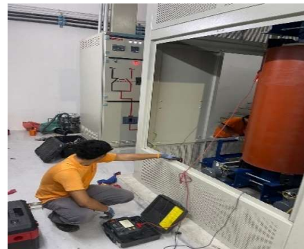
เจ้าหน้าที่ทำการตรวจสอบหม้อแปลงไฟฟ้า
