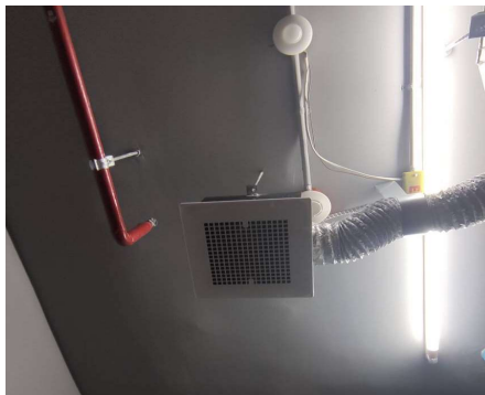
ระบบระบายอากาศห้องพัสดุฝอยรวม
