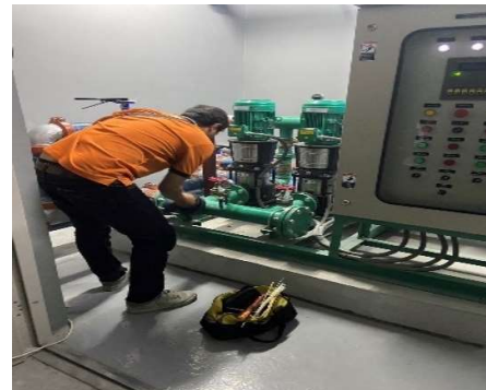
เจ้าหน้าที่ทำการตรวจสอบระบบ Booster pump
